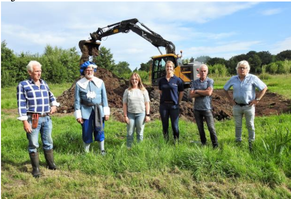
De start van de werkzaamheden
